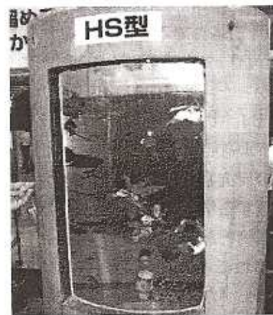
写真-4 雨水処理マンホール
